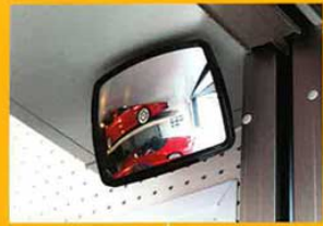
前方道路の左右を確認するためのミラーをシャッター上部にマグネットで設置。ドライバーズシートから見やすいように角度の調整が可能。
