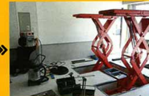
2013年7月11日、広島県にある「シーエス」田口さんの手により、造作式のリフトを設置。中古でありながらもきちんとレストアが施されたもので安心だ。
