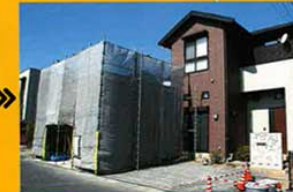
2013年2月23日、骨組みが組み立て1か月後は、木造1階がけによりかなりガレージの躯体ができてくる。まだ内装工事には至っていない。
