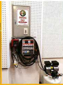
あらかじめリフトを購入することを前提にしたため、200V 単相から家庭用の3相に交換するインバータを用意。
