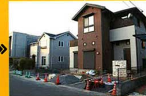
2013年1月下旬、敷地面積いっぱいにはガレージを建てるための基礎工事がスタート。家人への防音対策も重要だったので、防音対策をしたガレージを鉄骨で建てる。
