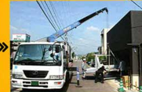
2013年7月27日、「タクニカル美術」製ホームパーク24の片持ちリフトが導入される。クレーンにより上げ、平行移動で設置している様子が見える。
