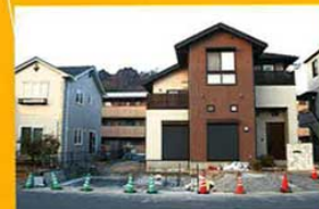
同時にレコーディングスタジオも完成したかったため同時に基礎工事もスタート。これもスタジオ建設にアイデアを出していたいた車屋の技術が大きい。
