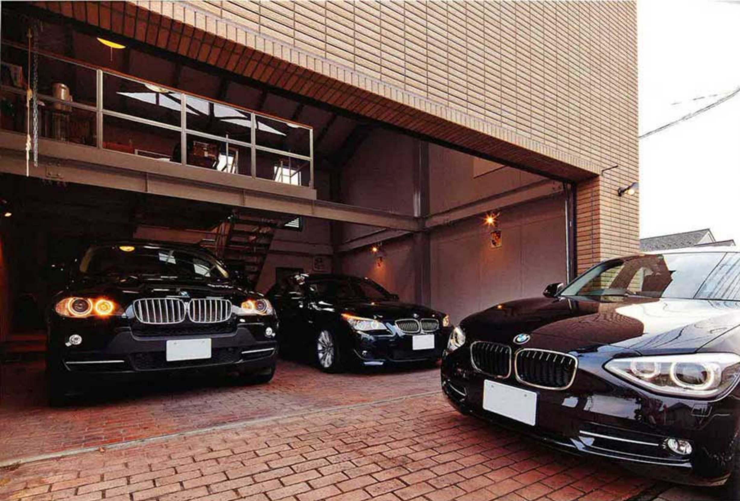
N邸の1つめのガレージ床面はスタンプコンクリートを施工。2階にロフトが設けられ、趣味部屋として使う予定だった。
