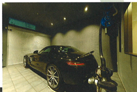
賃貸ガレージとしては珍しい、排気システムを導入。マフラーからの排気ガスをガレージの外にそのまま放出する仕組み。
