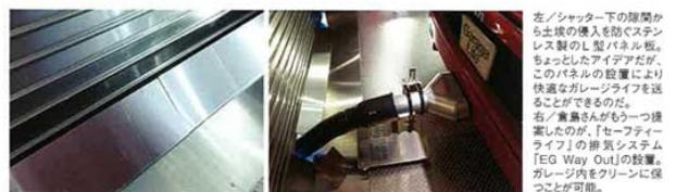
左／シャッター下の隙間から土埃の侵入を防ぐステンレス製のL型パネル板。ちょっとしたアイデアだが、このパネルの設置により快適なガレージライフを送ることができるのだ。
