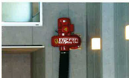
モーターで吸い上げられた排気ガスは外壁に設置された排気ダクトより排出。ダクトは小さくてシンプルなため、ガレージや家の外観に及ぼす影響も最小限だ。
