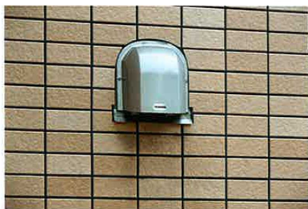
モーターで吸い上げられた排気ガスは外壁に設置された排気ダクトより排出。ダクトは小さくてシンプルなため、ガレージや家の外観に及ぼす影響も最小限だ。
