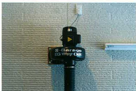
ガレージ内壁面に設置されるモーターは家庭用100V電源にて稼働。壁面にモーターを設置することで、非常に高い排気効率を実現している。オプションによりカラーリングやロゴを入れる変更が可能。
