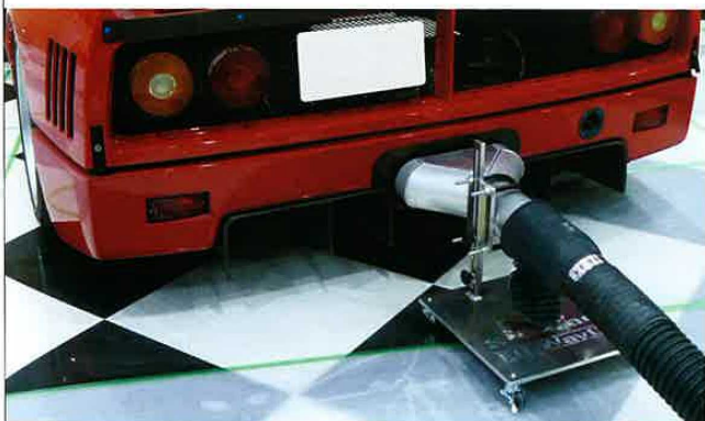
「EG WAY OUT」を導入したことで排気ガスの悩みを解決。リビングに導入された排気ガス排出システム設置例。マフラーエンドに合わせてアタッチメントもオーダー。強制的に排気ガスを排出するので、ガレージ内は常に新鮮な空気を保つ。
