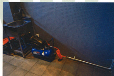
あらかじめエア配管を装備し、エアツールを使えるように設定されている。当然、エアツールは常備せず借主の持ち込みになるので注意しよう。
