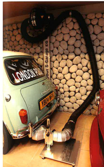
排気ガス排出システム「EGWAYOUT」のシングルを導入。狭いスペースに設置できるように90度の特別な加工が施された。
