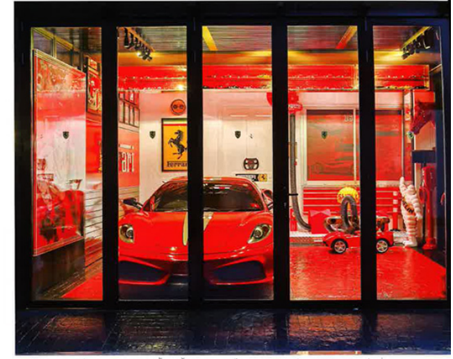
ประตูโรงจอดรถเป็นกระจกแบบบานเลื่อน พื้นโรงจอดรถเป็นคอนกรีตทึบฟลาย ใช้สีแดงเฟอร์รารีติดกับสีดำ เคลือบด้วย epoxy
